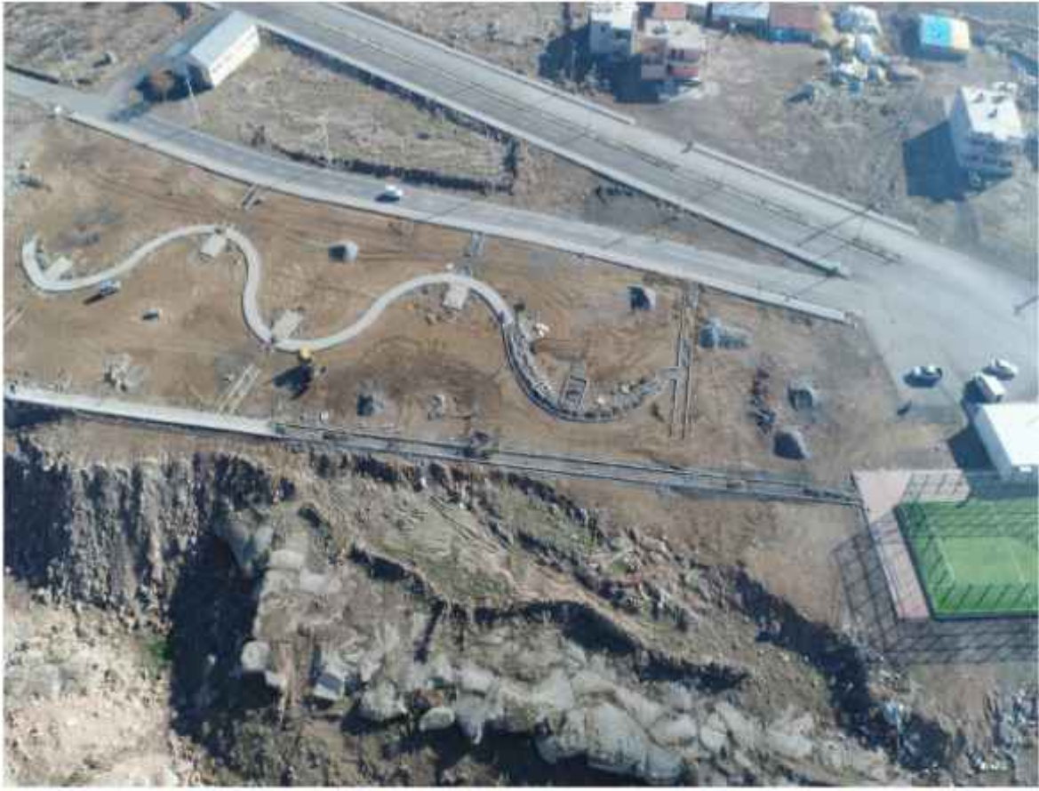
3. Etap TOKİ Konutları Park Yapımı Çalışmaları
