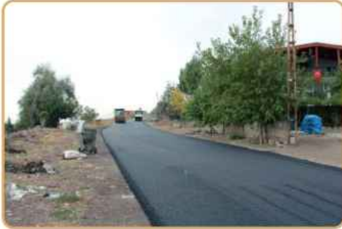
Örenşehir Mahallesi sıcak asfalt çalışması
