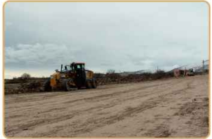
3.Etap yol yapımı
