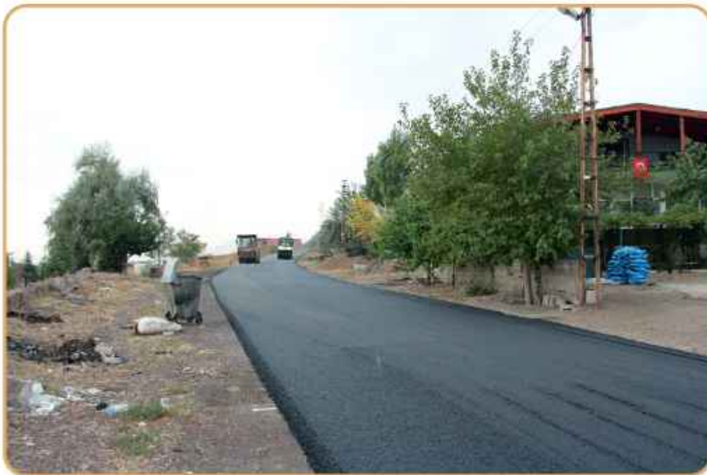
Örenşehir-Hamurcu arası sıcak asfalt
