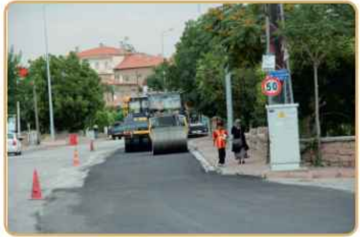
Şehir Merkez sıcak asfalt
