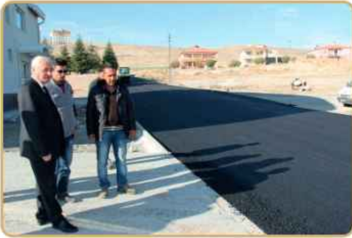
Süksün Mahallesi sıcak asfalt çalışması
