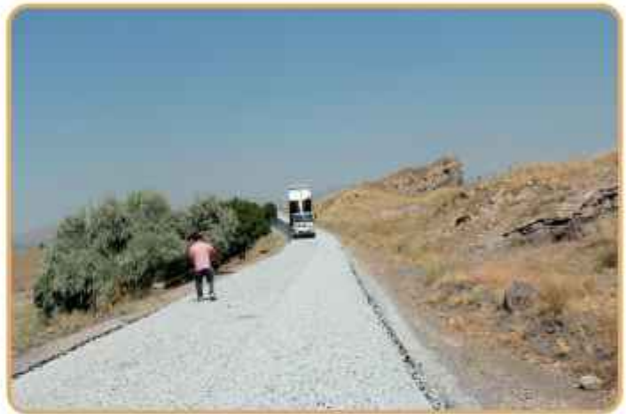
Sarıkürklü asfalt çalışması
