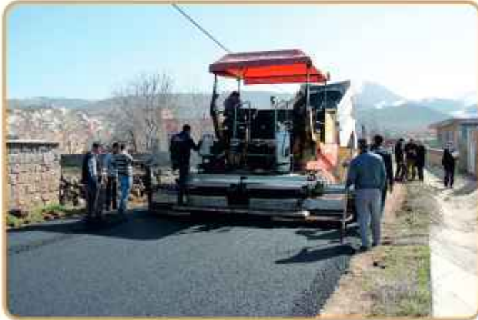
Kızılören sıcak asfalt
