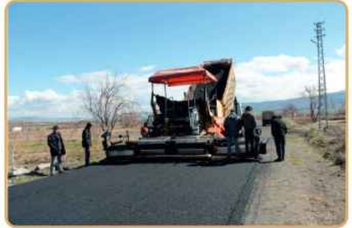
Garipçe Mahallesi sıcak asfalt çalışması
