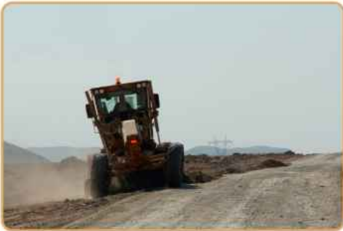
Şeyhşaban- Subaşı arası yol yapımı
