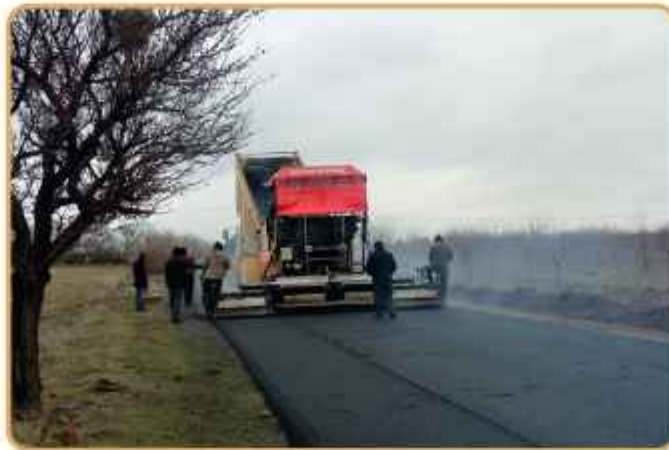
Bedir Bağları asfalt çalışması
