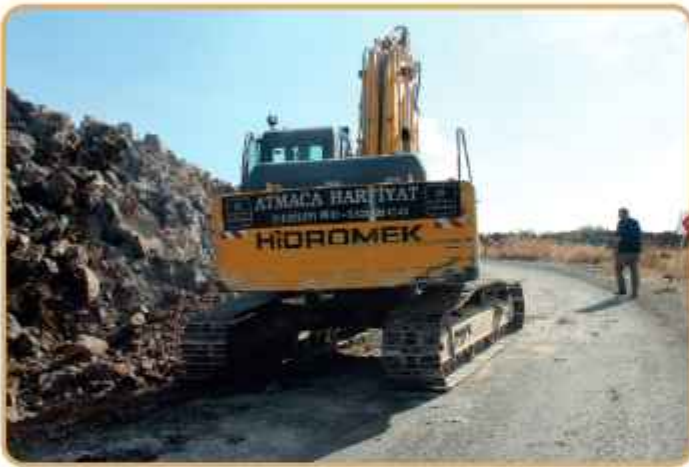
Kızılören yol genişletme çalışması
