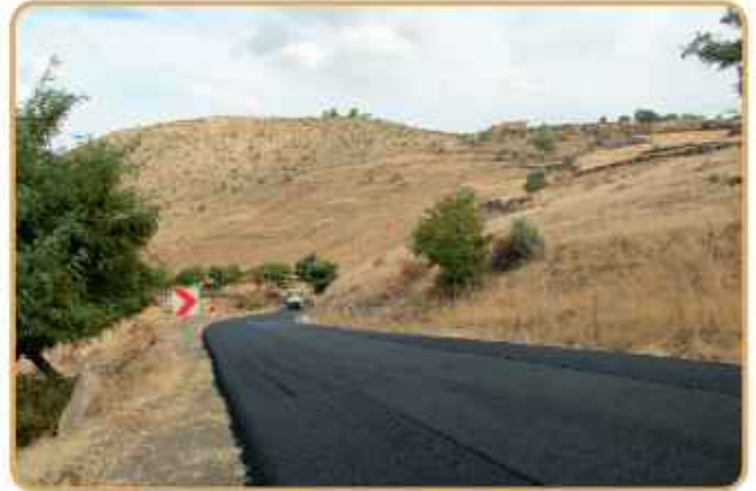
Kızılören sıcak asfalt
