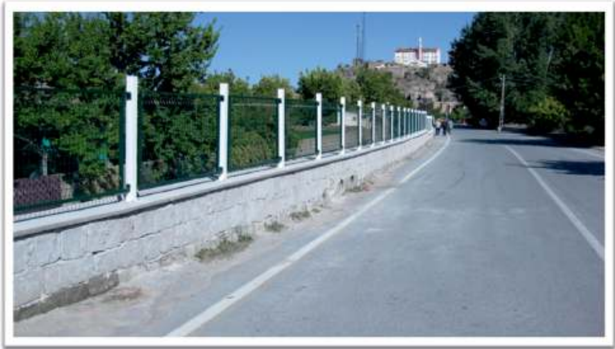
Taşkın koruma kanalı etrafı taş duvar
