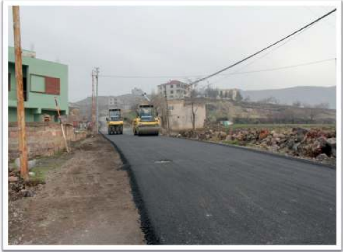
Kızılören Mahallesi sıcak asfalt çalışması
