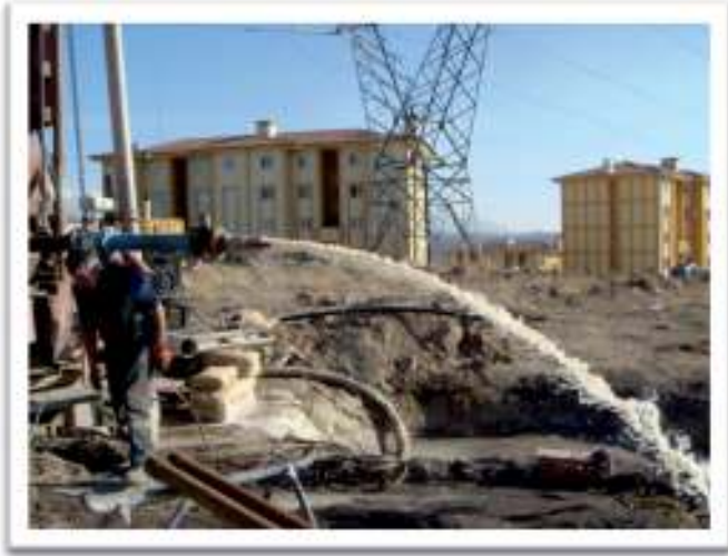
2.Etap TOKİ Sondaj Çalışması
