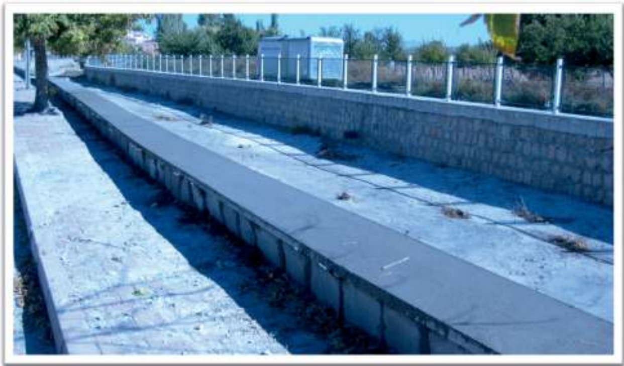
Taşkın koruma kanalı etrafı taş duvar
