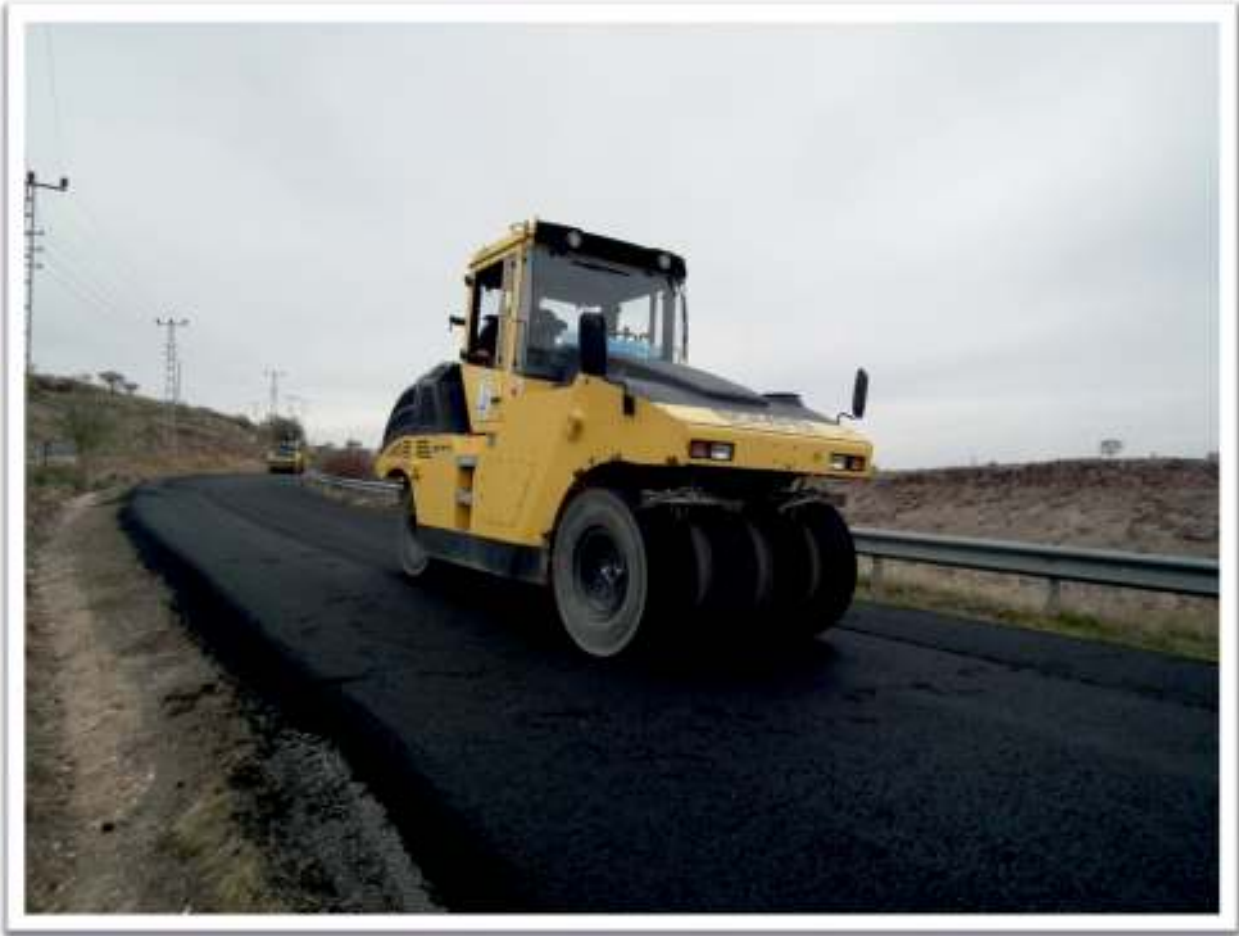
Derabağ baraj mevkii yolu sıcak asfalt çalışması
