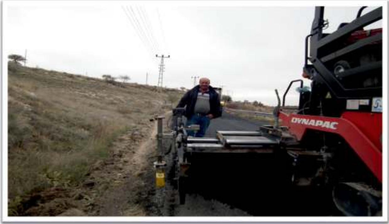
Derabağ baraj mevkii yolu sıcak asfalt çalışması
