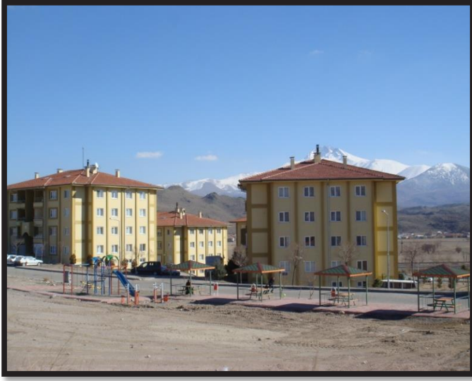
1.Etap TOKİ Sitelerinde kamelya ve oyun alanı yapımı
