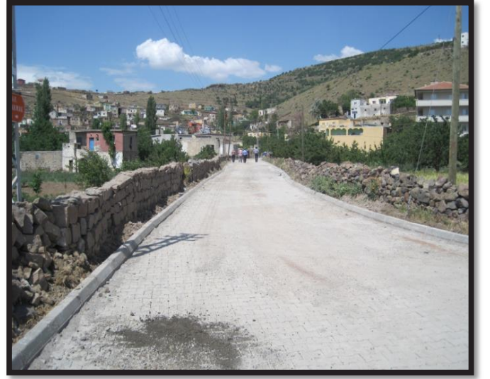
Kızılören Mahallesi Parke Çalışması
