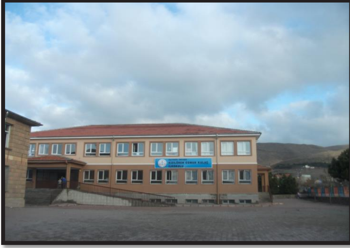
Osman Kulaç İlköğretim Okulu Bahçe düzenlemesi
