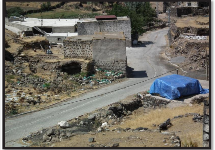
Ötebatan Mahallesi Parke Çalışması
