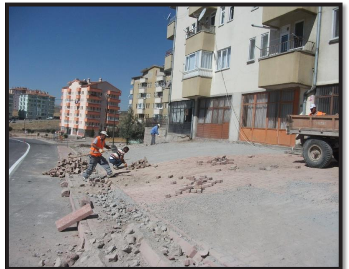
Gönenkent Mahallesi parke çalışması
