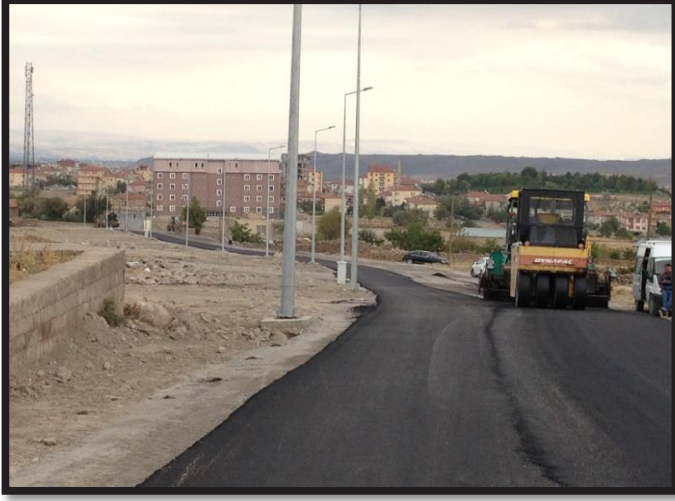
3.Etap Toki yolu sıcak asfalt çalışması
