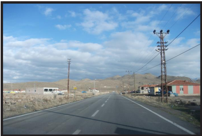
İstasyon Mevkii Sıcak Asfalt Çalışması
