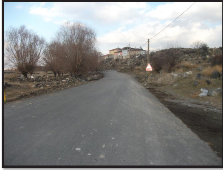
Dokuzpınar Sıcak Asfalt Çalışması
