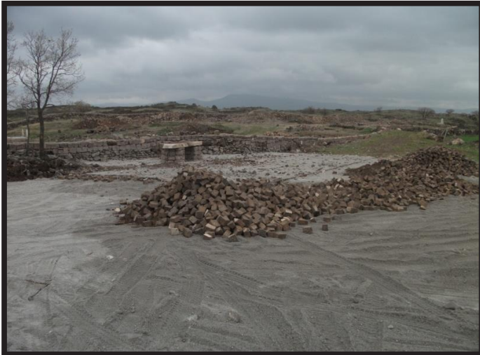
Kanlı Çardak Mezarlığı çevre düzenlemesi
