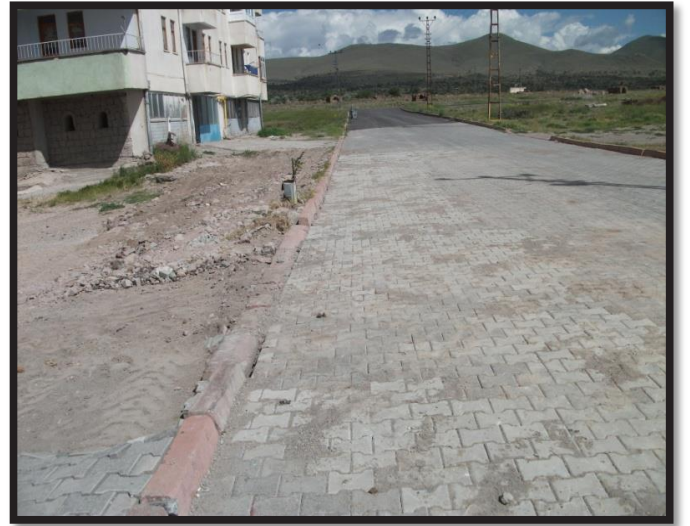
Gönenkent Mahallesi parke çalışması
