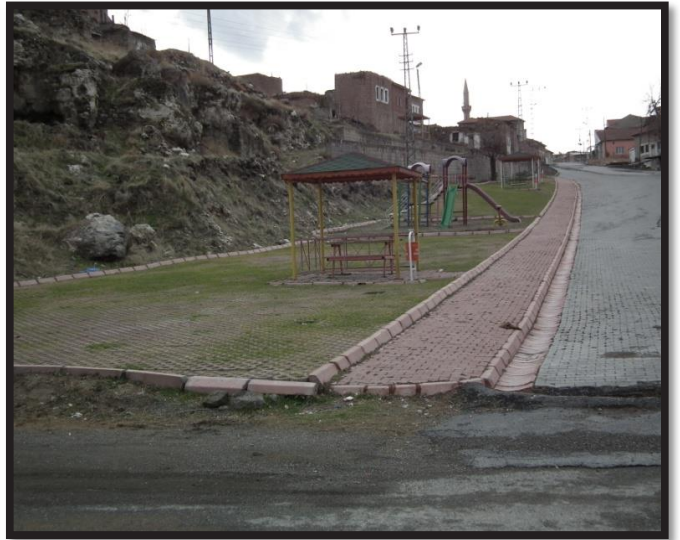
Süksün Cumhuriyet mahallesi park yapım çalışması
