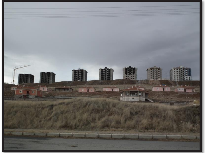
Süksün Afet konutları üzerine 260 konuttan oluşan 3. Etap TOKİ konutları inşaatı devam etmektedir.
