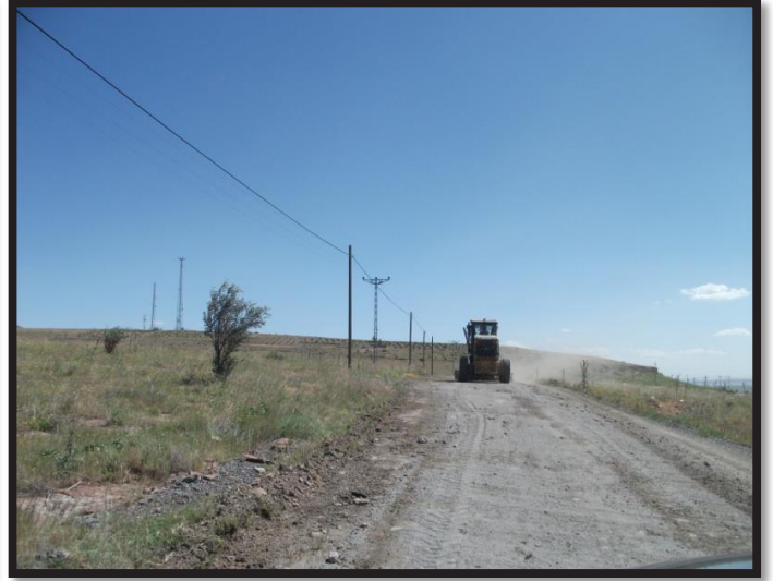
Garipçe küçük kum bağlarının yol yapım çalışması
