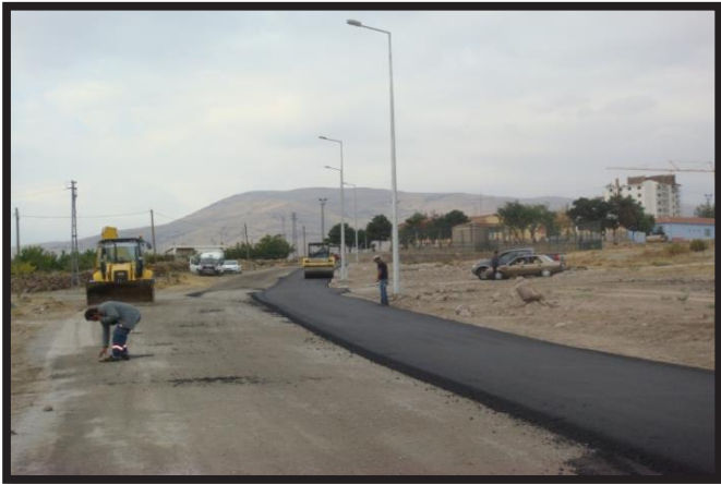
Semerkent Mahallesi Cezaevi Yolu Sıcak Asfalt Çalışması
