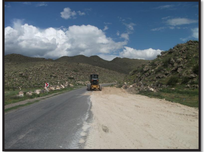
Kızılören yolunun genişletilmiş hali
