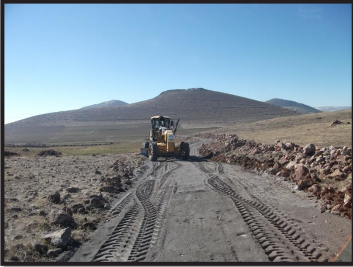
Üçkuyu-Garipçe arası yol açma çalışması
