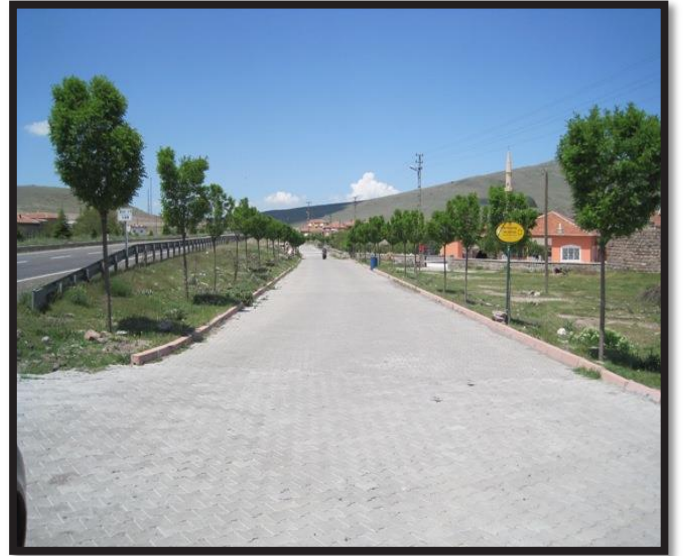
Garıpçe Mahallesi Parke Çalışması
