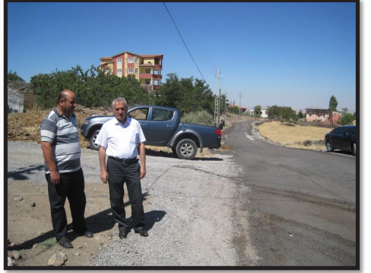
Kızılören’de satıh kaplama yol çalışması
