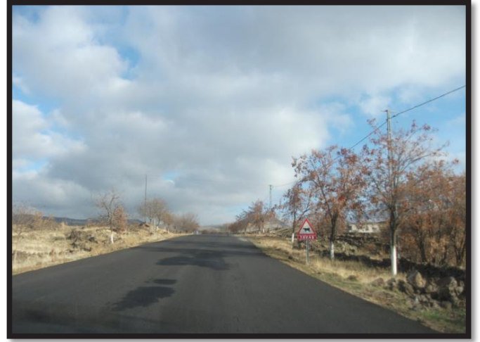
Kızılören Mahallesi Sıcak Asfalt Çalışması
