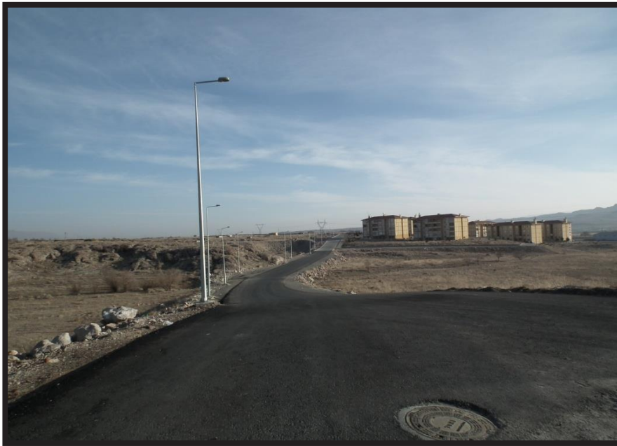
2.etap TOKİ ile 2. Etap TOKİ arasındaki yolun sıcak asfalt çalışması
