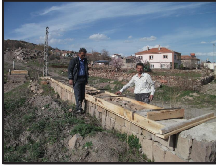
Sayacık Mahallesi Mezarlığı parke yapımı ve çevre düzenleme çalışması
