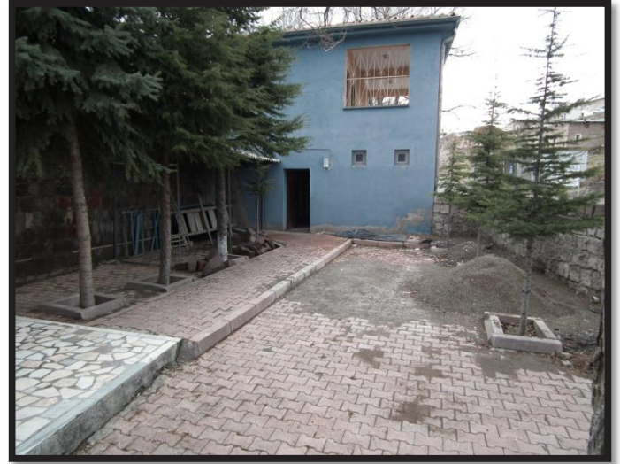
Süksün yukarı mahalle camii tuvalet onarımı ve çevre düzenlemesi
