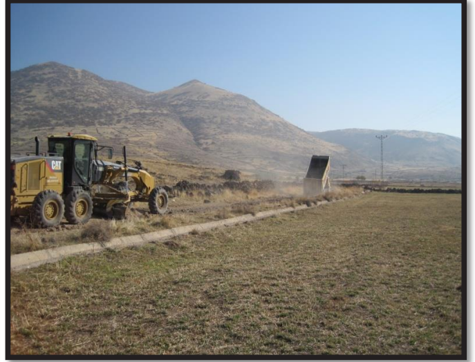
Subaőı Arazi yolu yapımı
