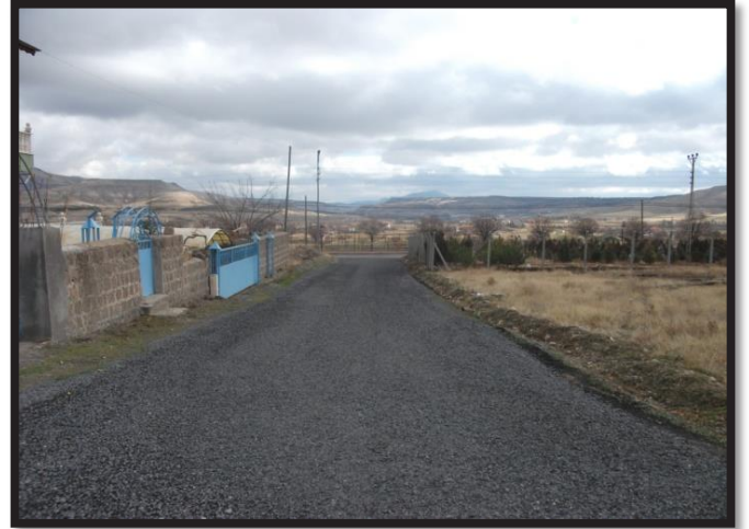
Süksün Mahallesi Sathi Kaplama Asfalt Çalışması
