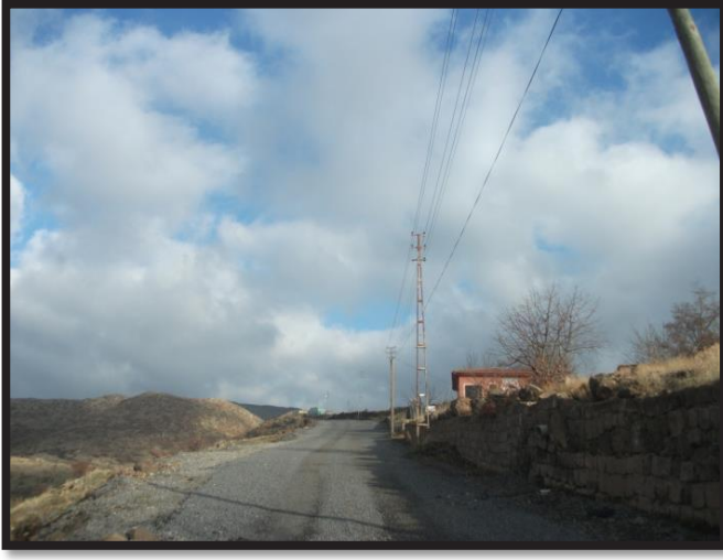
Kızılören Mahallesi Sathi Kaplama Asfalt Çalışması
