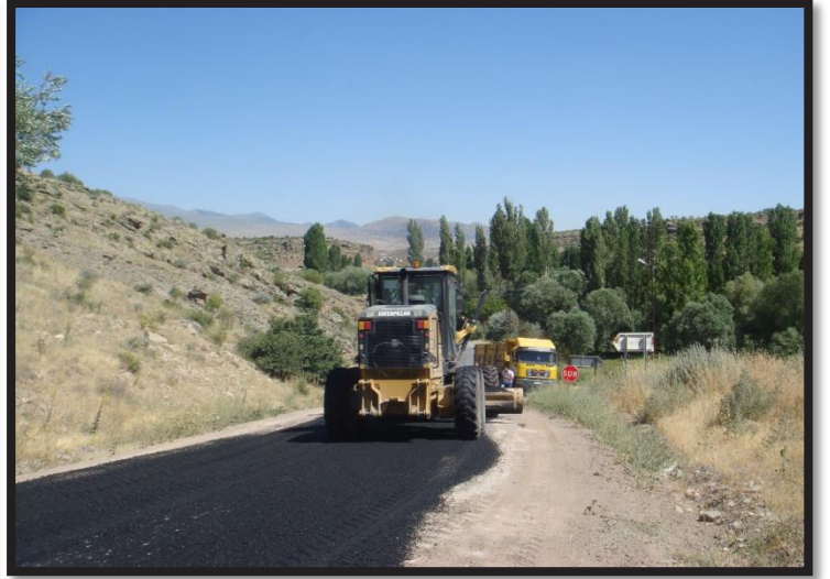
Üçkuyu – İncesu Yolu sıcak asfalt çalışması
