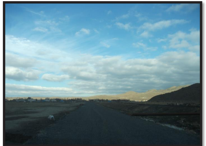
İstasyon Mevkii Sathi Kaplama Asfalt Çalışması
