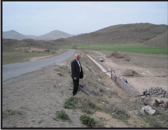
Kızılören yolu genişletme çalışmalarında istinat duvarı yapım çalışması
