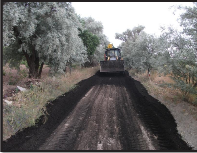
Eski Garipçe yolunun yapım çalışması
