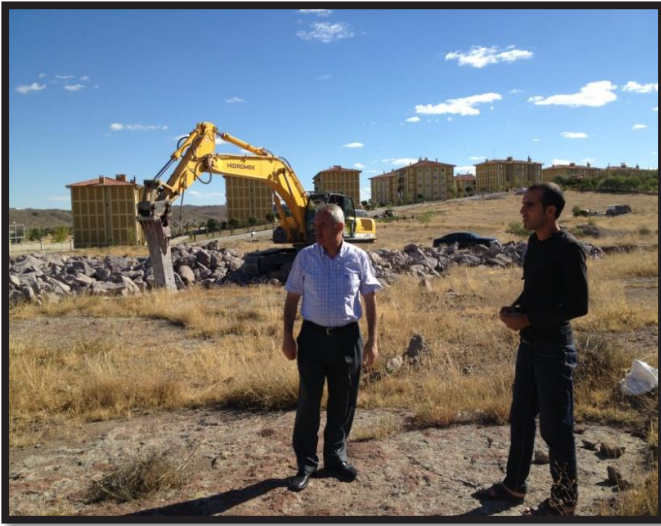
Bahçesaray Mahallesi 1. Etap Toki Şehit Yusuf Özmen İlköğretim Okulu arkasında Meslek Yüksek Okulu temel atma çalışmaları başlatıldı.
