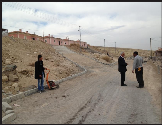
Süksün Mahallesinde Afet konutları Parke çalışması
