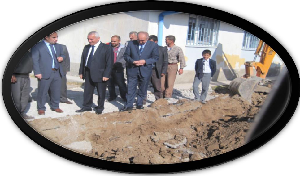
Tahirini İlköğretim Okuluna yapılacak Halı sahanın temelleri atılarak çalışmalara başlandı.
