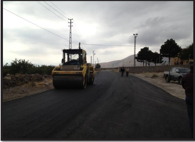
Semerkent Mahallesi Cezaevi Yolu Sıcak Asfalt Çalışması
