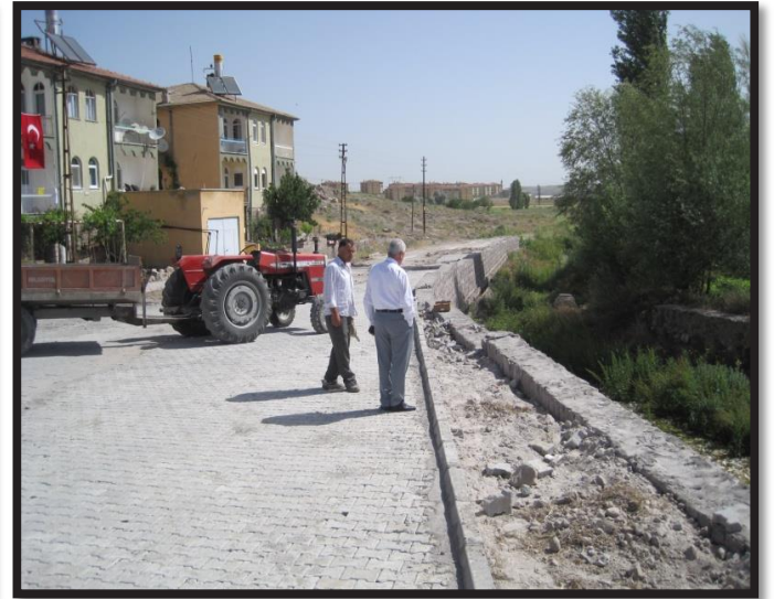
Gönenkent Mahallesi boyunca uzanan İncesu Deresi'nin ıslah çalışmalarında dere kenarına duvar çekilerek , üst kısmındaki caddeye parke döşendi
