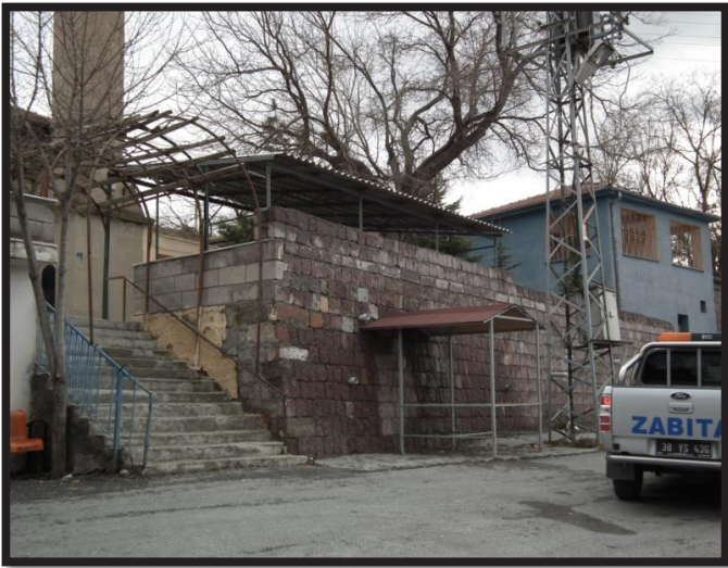
Yukarı camii bahçe duvarı
