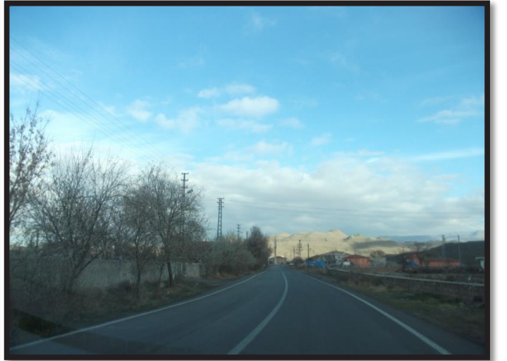
İstasyon Mahallesi Sıcak Asfalt Çalışması
