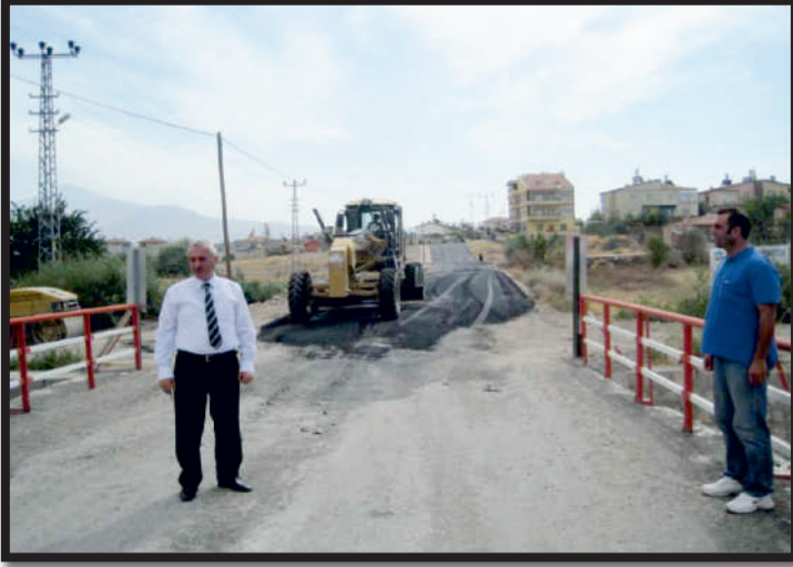
Bahçelievler Mahallesi ile Gönenkent Mahallesi arasında yeni imara göre açılan yolun sıcak asfaltla kaplanması
