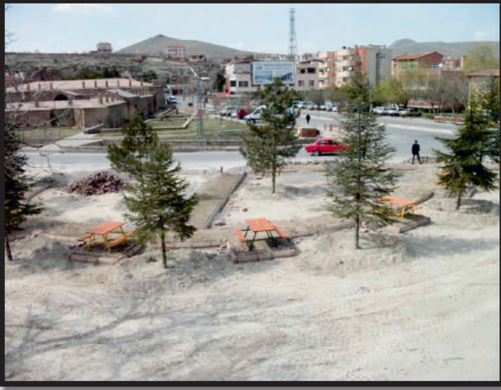
Üç göz köprü parkının yapımı
