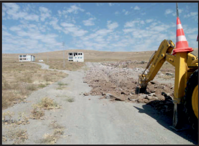
Örenşehir Mahallesinde kanalizasyon çalışması
