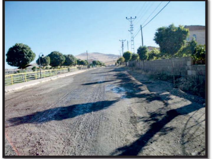
Süksün Mahallesinde sıcak asfalt öncesi yolun düzeltilmesi
