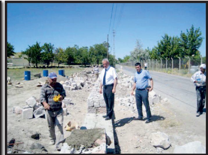
Bahçelievler Mahallesi İstasyon caddesinde ihate duvarı yapımı
