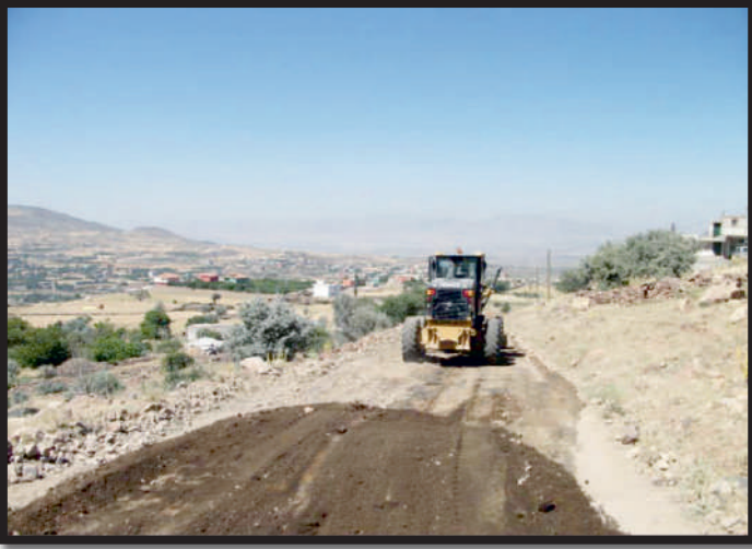
Kızılören Beşkuyu yolu ıslah çalışması
