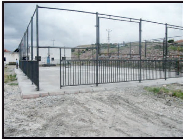
Saraycık Mahallesinde Basketbol sahası yapım işi
