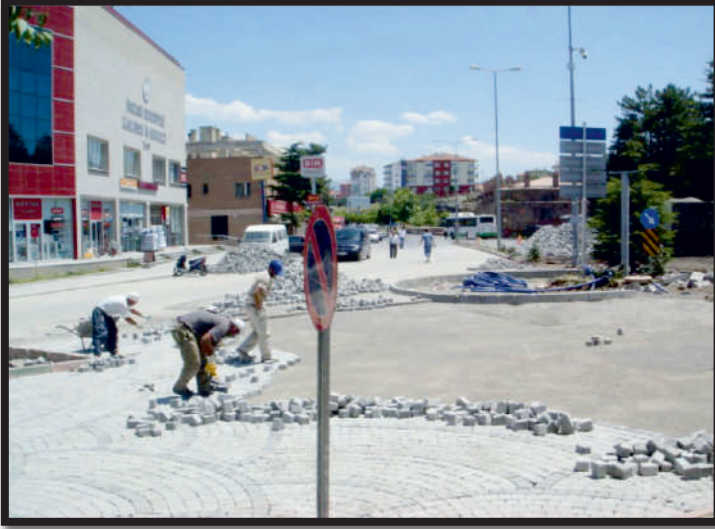
Karayol İş Merkezi önündeki kavşakta parke çalışması
