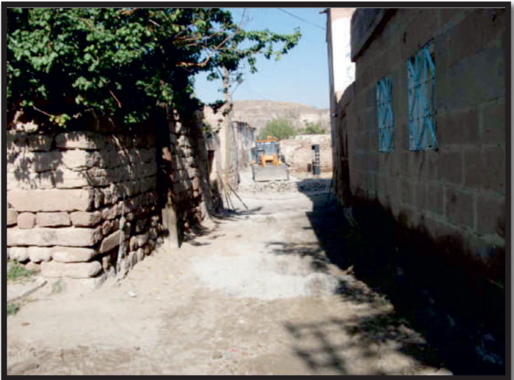
Yarım Mahalle de alt yapı çalışması
