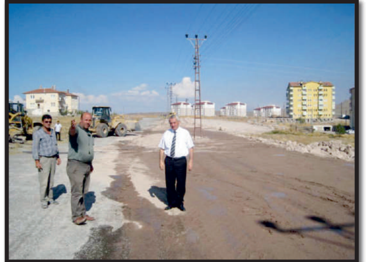
Gönenkent Mahallesi'nden Bahçesaray mahallesinde bulunan 2. Etap TOKİ konutları arasındaki yolun açılma çalışması
