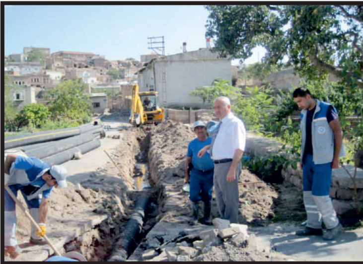
Yarım Mahalle'de kanalizasyon çalışması
