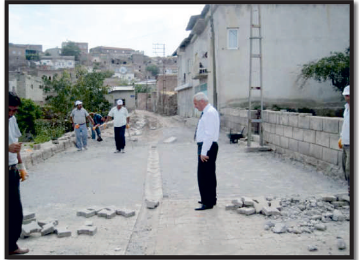
Yarım Mahalle parke çalışması
