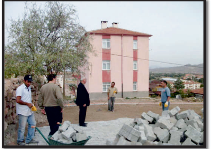
Kara Mustafa Paşa Mahallesi Damardı mevkiinde parke çalışması
