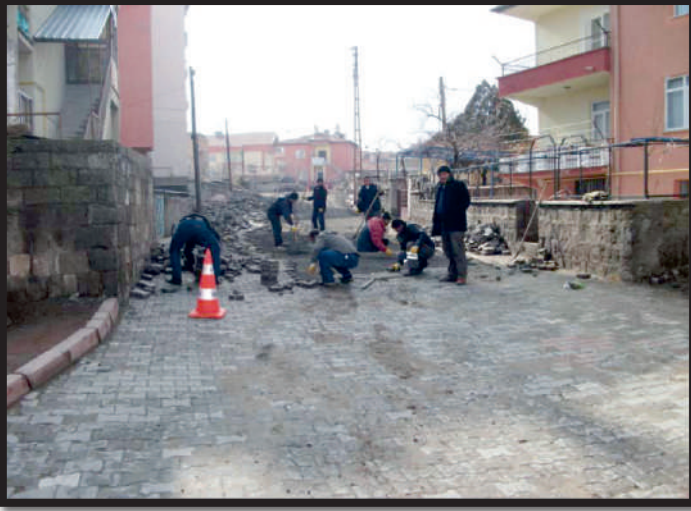
İhsanaras mahallesinde parke çalışması
