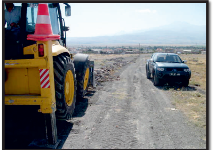
Örenşehir Mahallesinde yol ıslah çalışması
