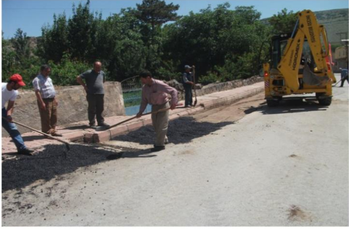
Kızılören'in ana caddelerinde asfalt yama işi
