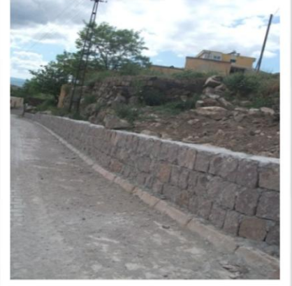
Kızılören'de İstinad duvarı yapım çalışması
