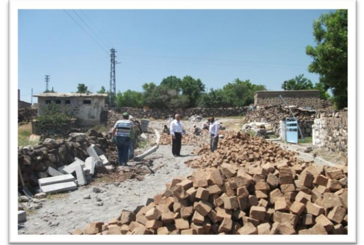
Santırın Çardak'ta Arnavut kaldırımı döşeme çalışması
