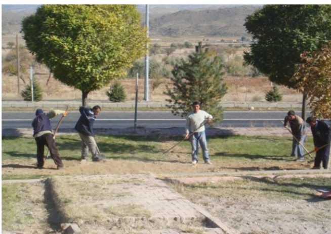
İncesu Parkında sulama sistemi döşeme çalışması
