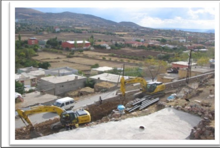
Kızılören'de kanalizasyon şebekesi yapımı
