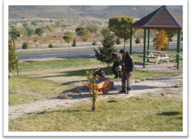
İncesu Parkında bakım ve onarım
