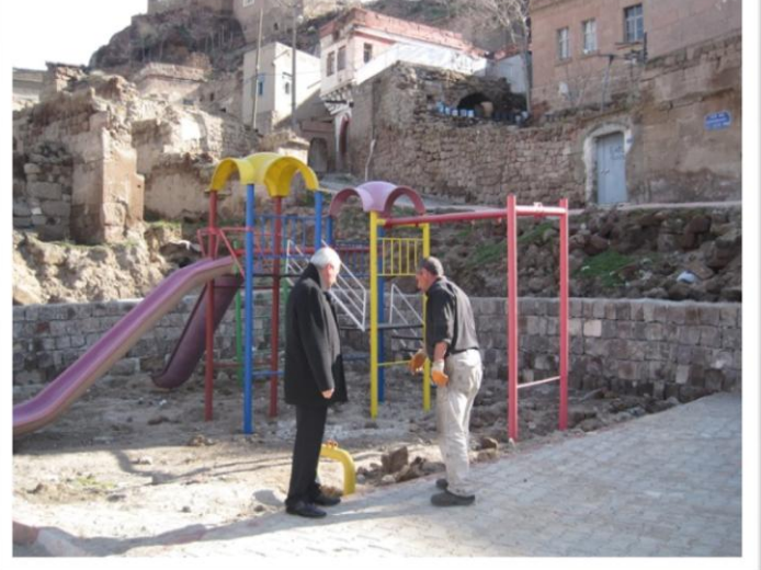
Yarım mahallesi'in de park yapım çalışması
