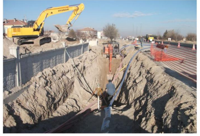
Süksün Kanalizasyon şebekesi Kayseri Büyükşehir Belediyesi Ana kolektör hattına, İçme suyu ise ana içme suyu şebekesine bağlama çalışması
