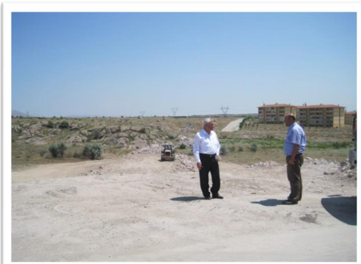
1.Etap ve 2. Etap Toki konutları arasında yeni yol açılma çalışması
