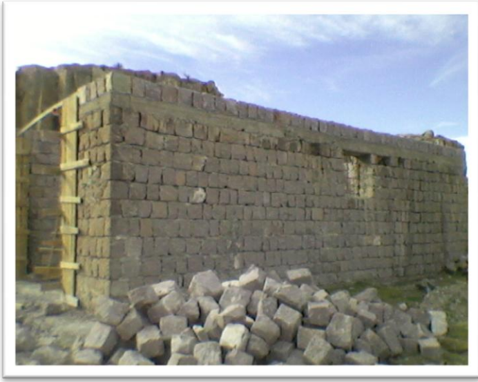
Tarımla uğraşan Süksün Halkının buğday ilaçlamak için kullanacakları sellektör binası yapımında devam edilmektedir.
