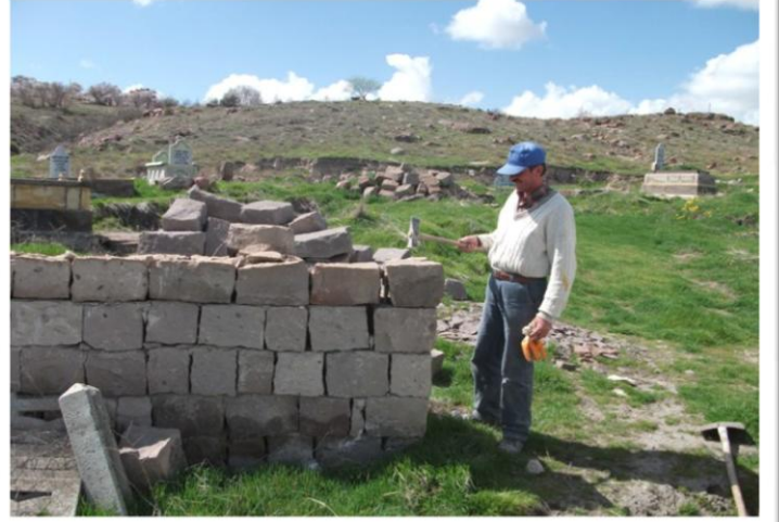
Saraycık mahallesi mezarlığında çevre düzenlemesi kapı ve duvar yapım işi
