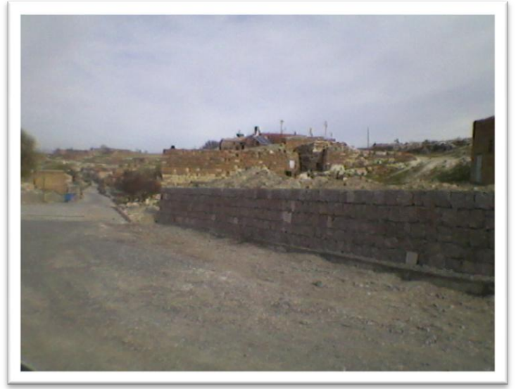
Süksün mezarlığında ihate duvarı yapımı
