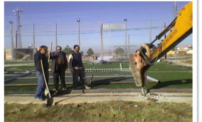
Hava şartlarından zarar gören Kızılören'de bulunan halı sahada onarım çalışmaları
