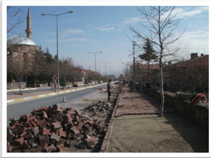
Bahçelievler mahallesinde doğalgaz boru hattı geçen yaya kaldırımları yenilendi
