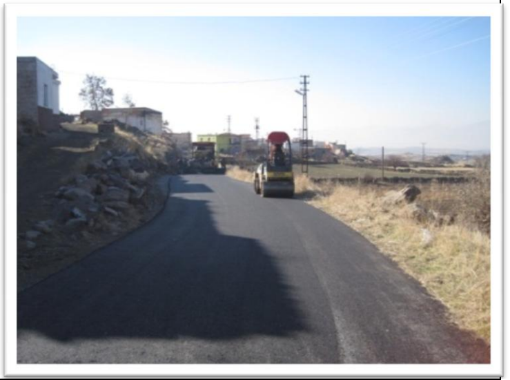
Kızılören'de 1500 rakım yükseklikte ki Ötebatan mahalesini Boğaz Çardak'a bağlayan yolun sıcak asfaltlama çalışmaları
