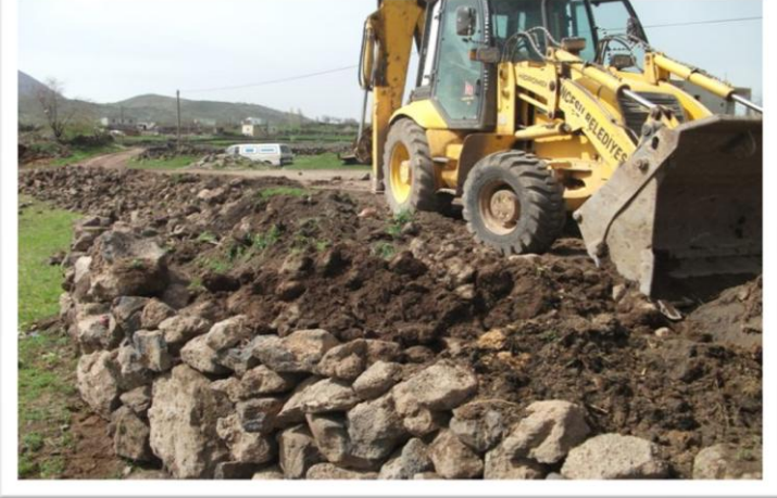
Kızılören Gölbaşına yapılacak 3. Etap Toki konutları için yol açma çalışmaları ve duvar yapımı
