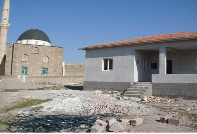
Garipçe Mahallesi'ne sosyal tesis yapımı
