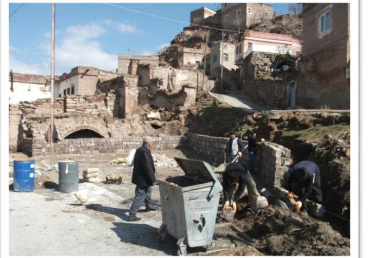
Yarım Mahalle istinad duvarı yapımı
