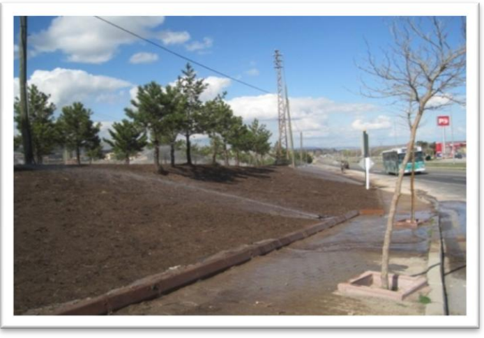
Bahçelievler mahallesinde bulunan Bayrak Parkının yapımı
