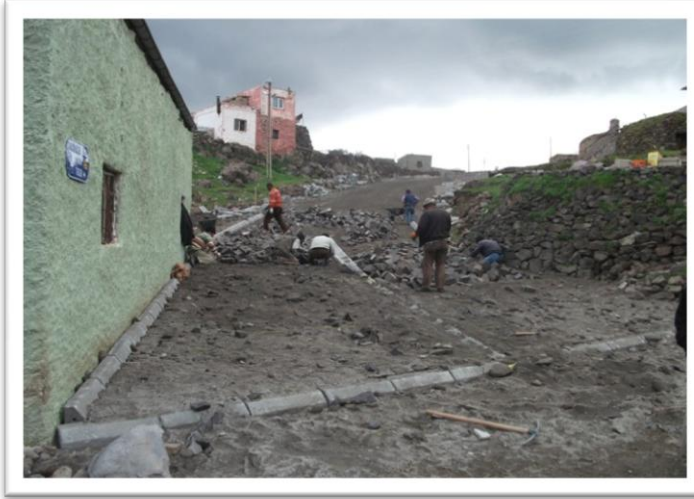
Çardaklıda parke çalışması
