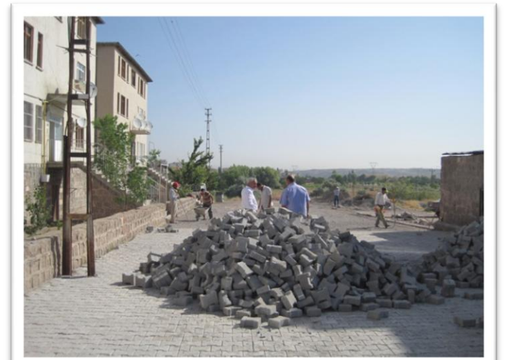
Bahçelievler mahallesinde parke döşeme çalışması
