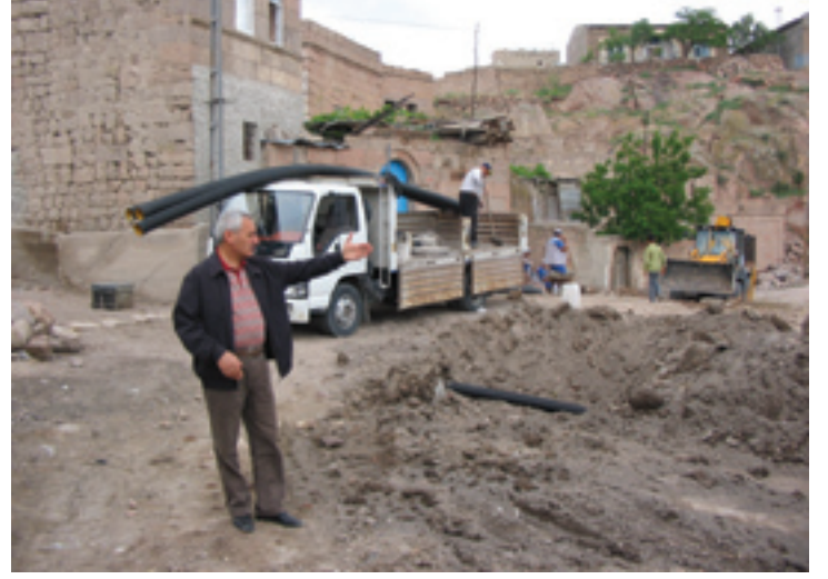
Bulgurcu Mahallesi Su Hatlarının Yenilenmesi
